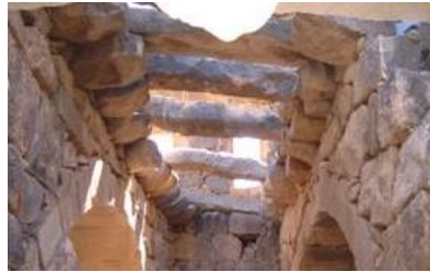
الصورة (3)، (4): توضح طريقة تنفيذ الأسقف يستخدم الشبائح والعقود الحجرية في قرية جابر السرحان
