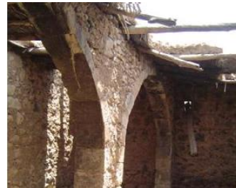
الصورة (5)، (6): توضح طريقة التسقيف باستخدام العوارض الخشبية في قرية جابر السرحان
