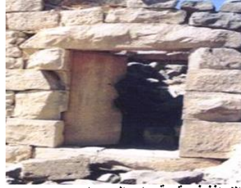
الصورة (7),(8): توضح طريقة تنفيذ الأبواب والنوافذ في قرية جابر السرحان.
