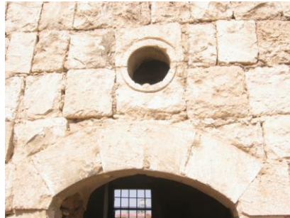
الصورة (25),(26): توضح طريقة تصميم بناء الواجهات الأمامية للمسكن التقليدي في المدور
