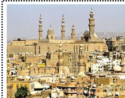
شكل رقم (3): منطقة السيدة زينب، وسط القاهرة المصدر: الباحث
