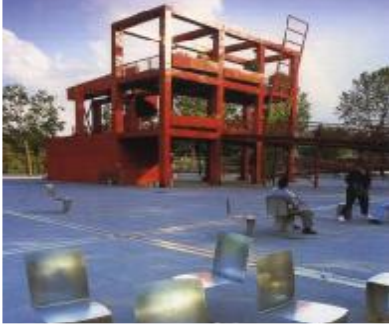
شكل رقم (22): الفكر التفكيكي المعاصر كمدخل تصميمي للمناطق المفتوحة المصدر: الجهاز القومي للتنسيق الحضاري، 2010
